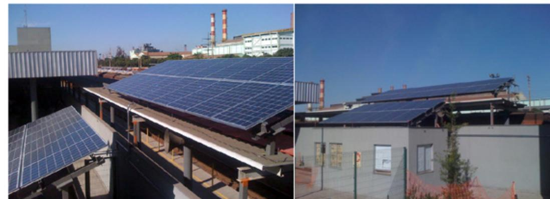
Figura 2 – Sistema fotovoltaico instalado sobre o telhado em uma estação de trem – Ipatinga, Minas Gerais.
