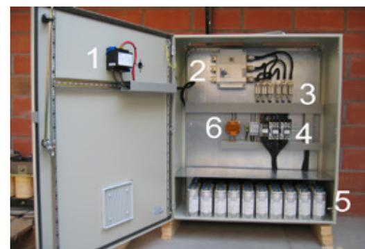
Figura 15 – Quadro de controle de fator de potência, composto por: 1) Controlador; 2) Chave seccionadora; 3) Fusíveis; 4) Contatores; 5) Capacitores; 6) Fonte de alimentação.
